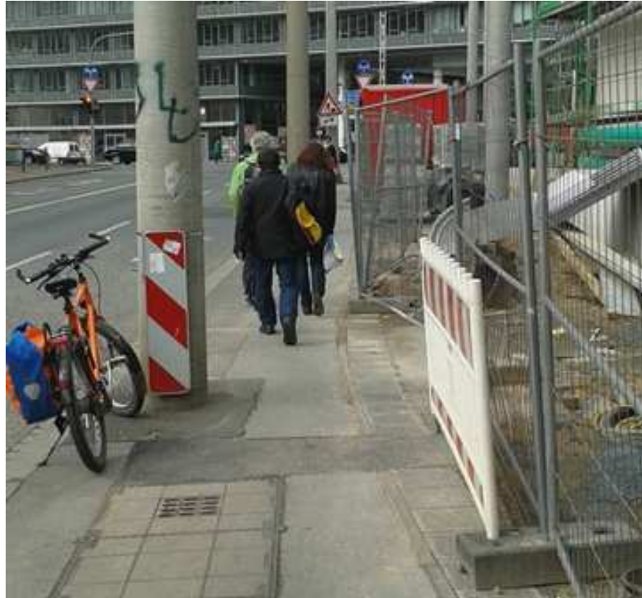
Allersberger Straße 04/2015: Und die Baustelle breitet sich aus.
