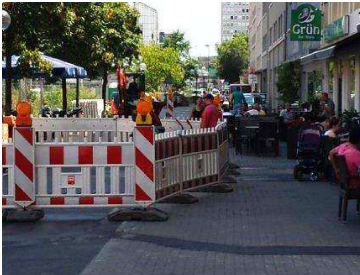
Fürther Straße 07/2015: Jetzt wird's eng ...
