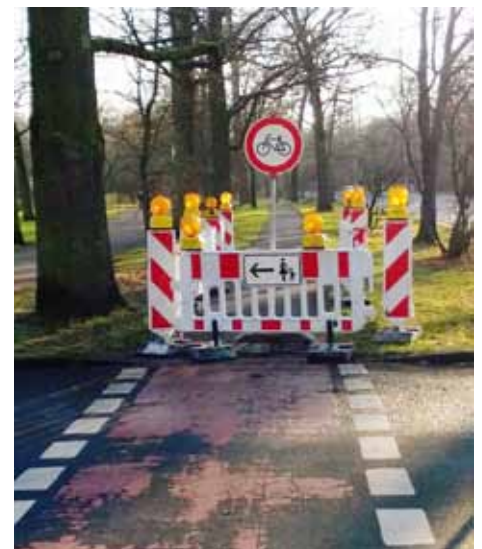
Baustelle Münchener Straße (Foto: Rainer Kuhnlein)
